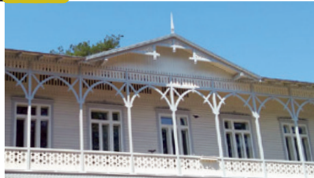
Sanatorium Gurewicza, ul. Armii Krajowej i Filipowicza, Otwock przed renowacją (2014 r.) i po renowacji (2021 r.),
