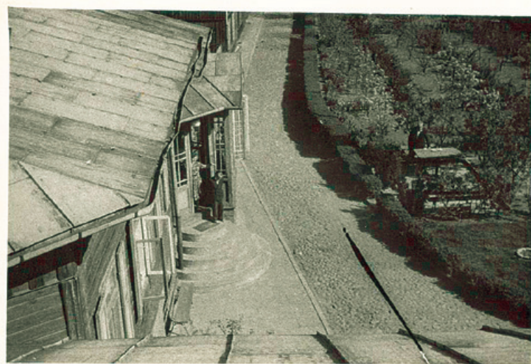
Widok na budynek i fragment ogrodu. Ogród ciągnął się aż do ulicy Bulwarnej. Zdjęcie wykonano z dachu drugiej części budynku.
