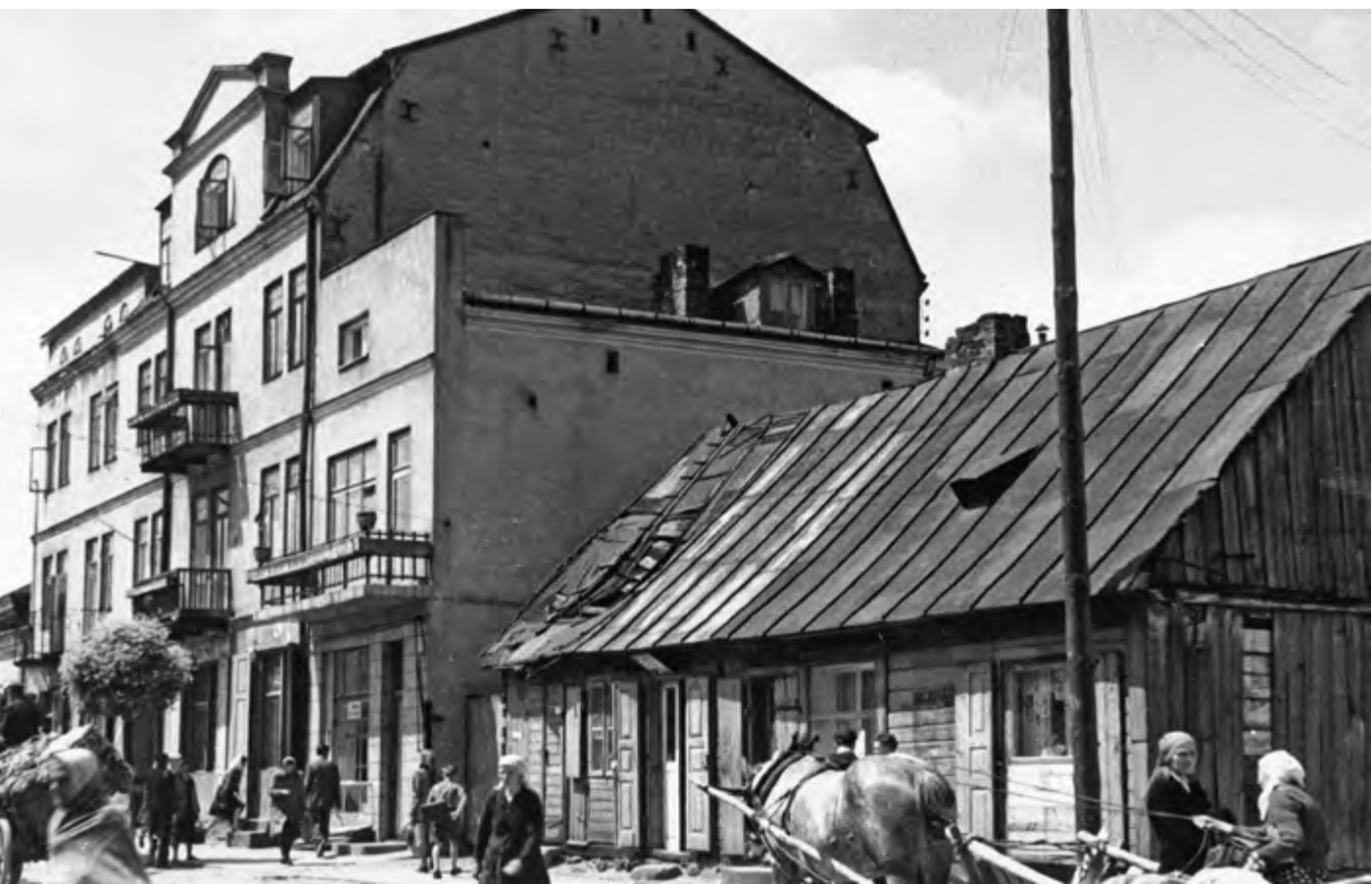
Zróźnicowana zabudowa zachodniej strony ul. Świerczewskiego (obecnie ul. Piłsudskiego). Fot. z 1953 r. Źródło: NID, Studium.
