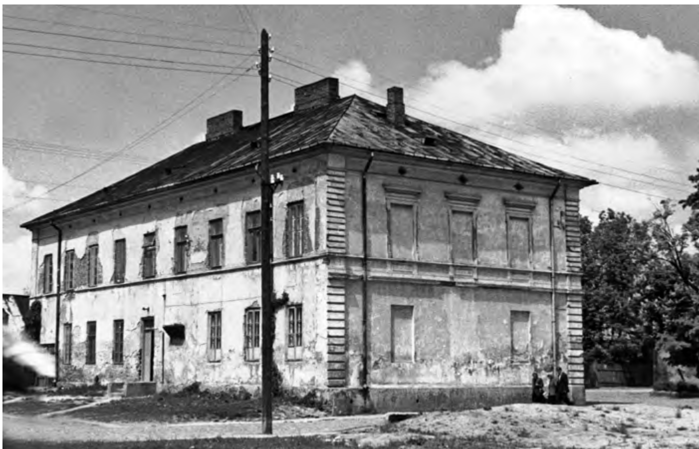
Budynek klasycystyczny projektu H. Marconiego, wybudowany w latach 1847-1853, znajdujący się w rynku sandomierskim (obecnie pl. Kilińskiego). Widok od ul. Świerczewskiego (obecnie ul. Piłsudskiego). Fot. z 1953 r. Źródło: NID, Studium.
