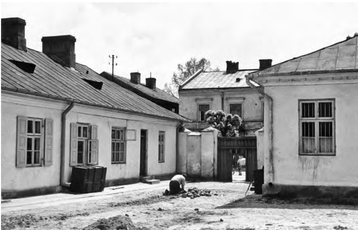
Budynek poczty z początku XIX w. znajdujący się przy ul. Stalina 53 (obecnie ul. Warszawska). Widok od strony dziedzińca. Fot. z 1953 r. Źródło: NID, Studium.
