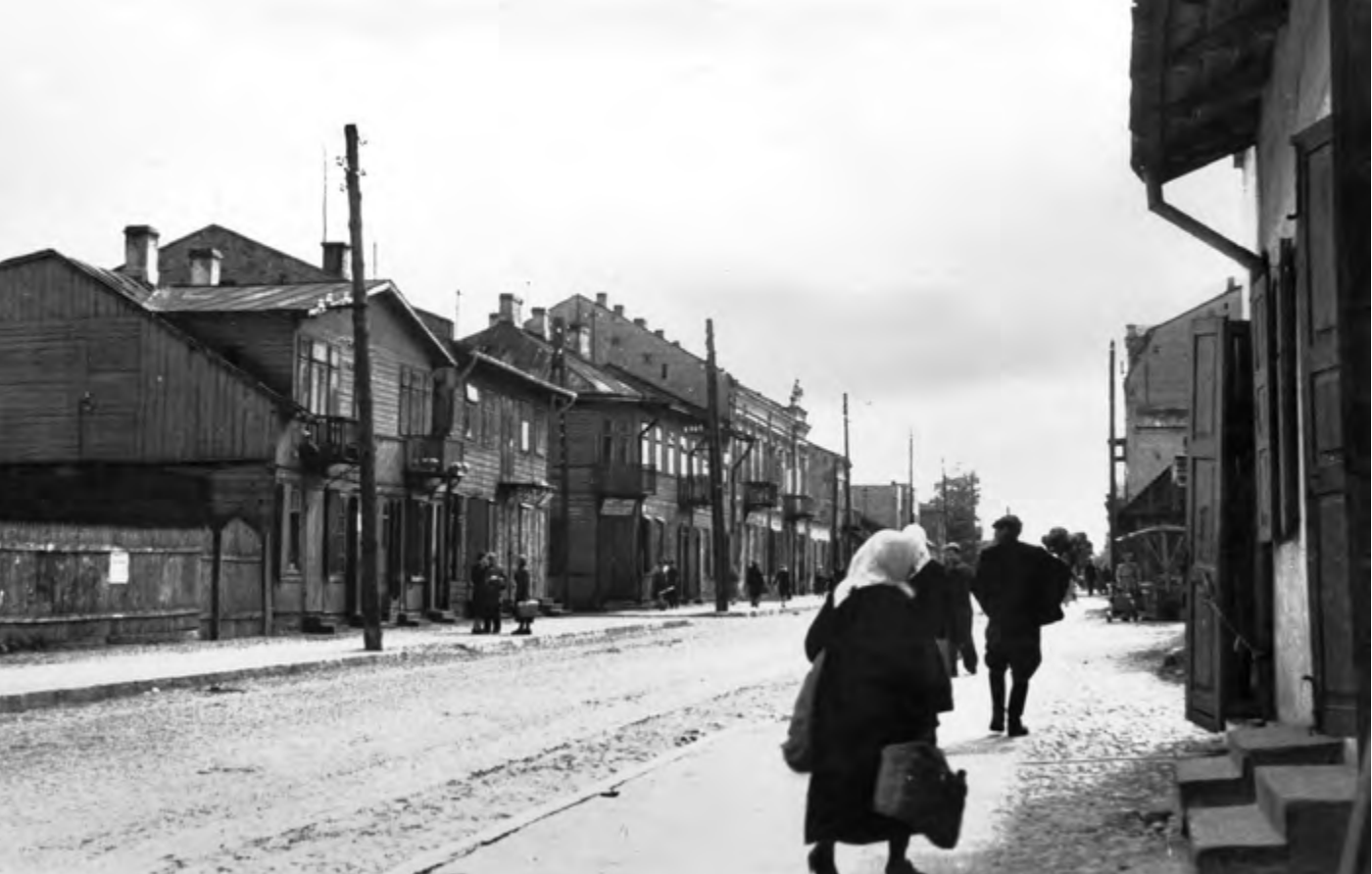
Wschodnia zabudowa ul. Świerczewskiego (obecnie ul. Piłsudskiego). Fot. z 1953 r. Źródło: NID, Studium.
