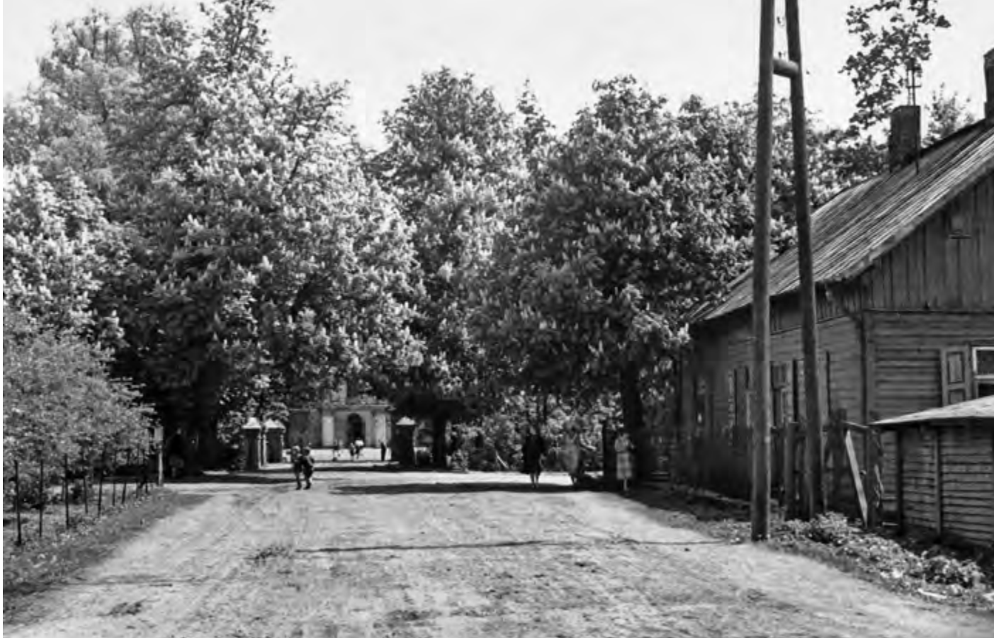
Stary trakt, na osi którego znajduje się pałac. Widok z ul. Topolowej na bramę wjazdową do pałacu Dernałowiczów. Fot. z 1953 r. Źródło: NID, Studium.
