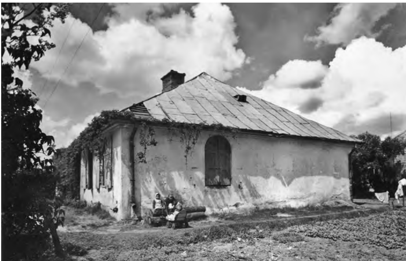
Dworek Michała Elwiro Andriollego znajdujący się przy ul. Stalina 173 (obecnie ul. Warszawska). Obiekt z pierwszej połowy XIX w. Wschodnia elewacja budynku. Fot. z 1953 r. Źródło: NID, Studium.
