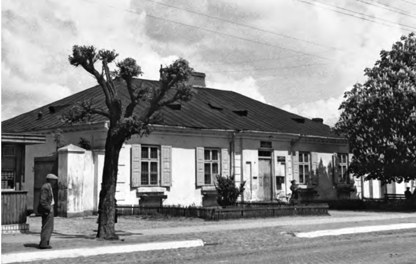
Budynek poczty wybudowany w stylu klasycystycznym na początku XIX w. znajdujący się przy ul. Stalina 53 (obecnie ul. Warszawska). Elewacja frontowa. Najstarszy budynek urzędowy w Mińsku Mazowieckim. Fot. z 1953 r. Źródło: NID, Studium.
