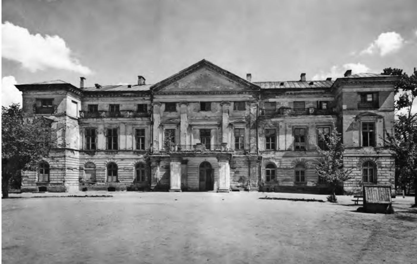
Pałac Dernałowiczów – elewacja frontowa. Fot. z 1953 r. Źródło: NID, Studium.
