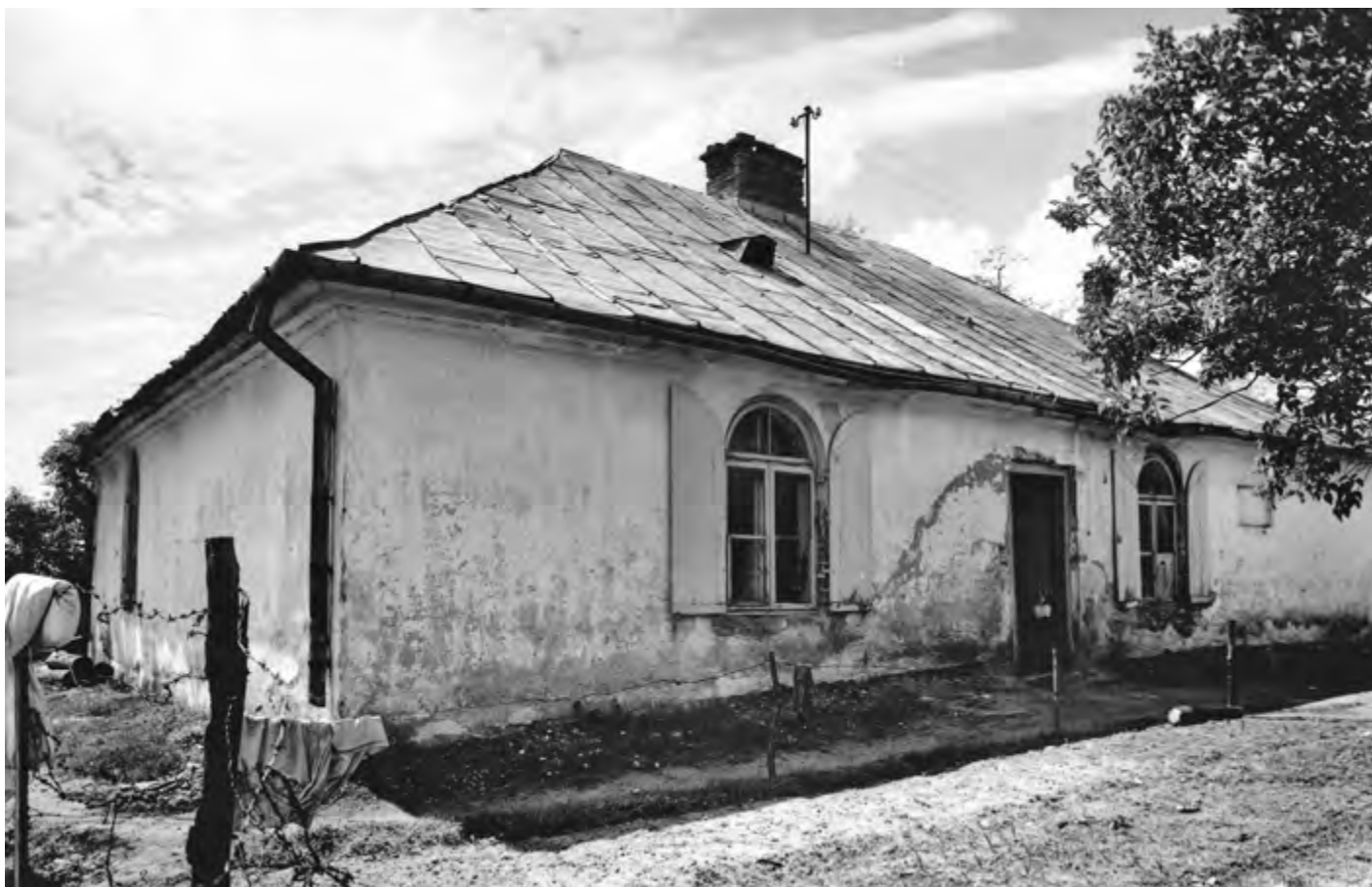
Dworek Michała Elwira Andriollego przy ul. Stalina 173 (obecnie ul. Warszawska). Widok elewacji bocznej i części tylnej. Fot. z 1953 r. Źródło: NID, Studium.
